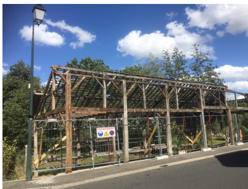
Démontage des anciens chevrons
