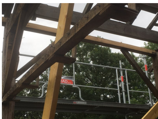
Remplacement d'une panne sablière
