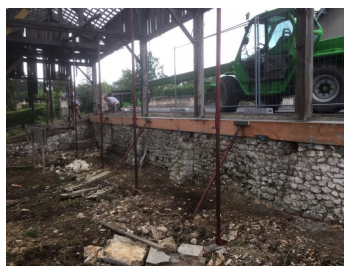
Reprise des soubassements par l'entreprise Perche-Couverture
