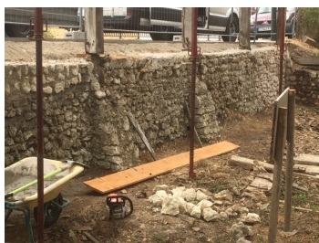
Reprise des soubassements par l'entreprise Perche-Couverture
