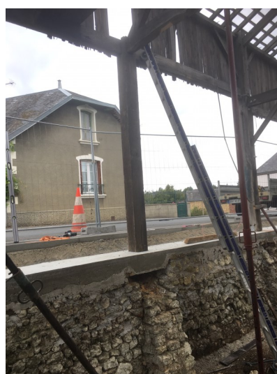
Soubassement et remplacement de l'IPN par un poteau
