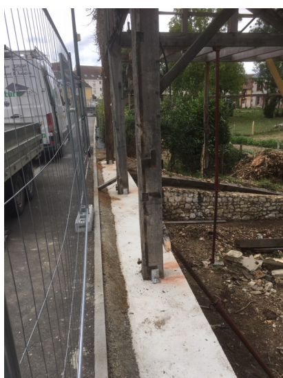
Soubassement et remplacement de l'IPN par un poteau
